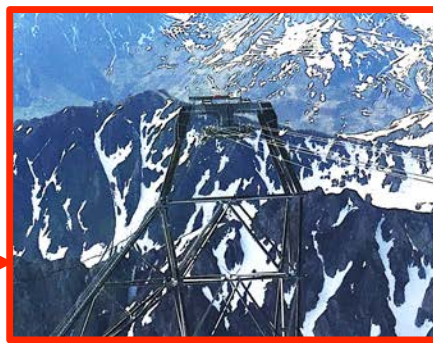
Avec une luminosité différente, le pylône est discernable
